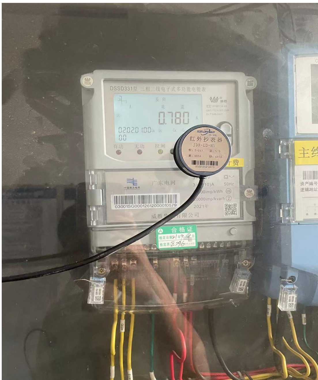
3.3.2 红外抄表器安装完毕示意图
